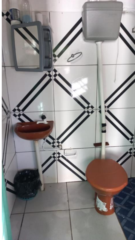
Figura 3 – Banheiro do imóvel
