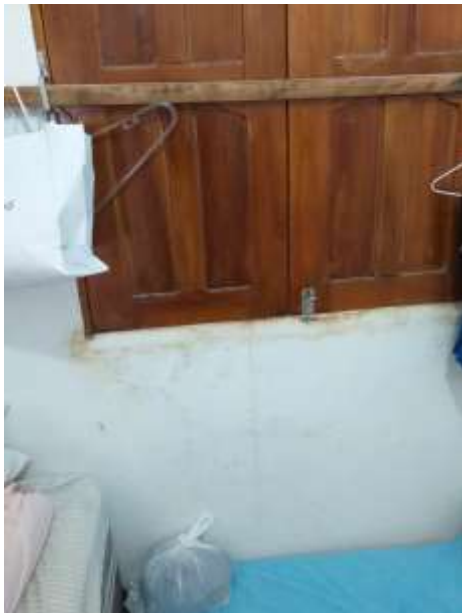
Figura 09: Ambiente Existente Atualmente.
