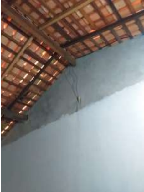
Figura 03: Ambiente Existente Atualmente.
