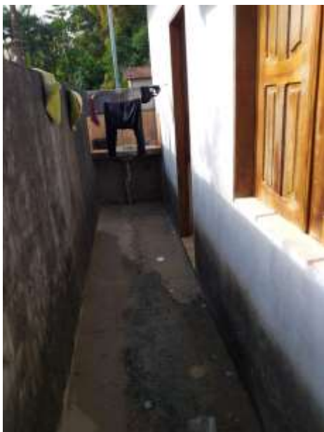
Figura 13: Ambiente Existente Atualmente.
