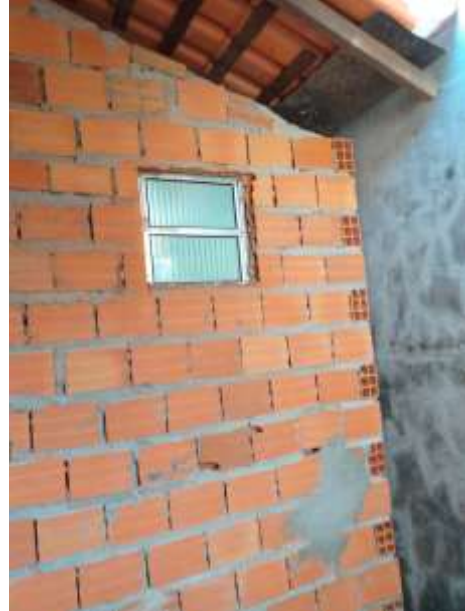
Figura 08: Ambiente Existente Atualmente.
