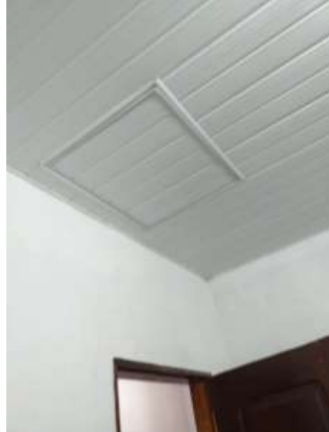
Figura 04: Ambiente Existente Atualmente.
