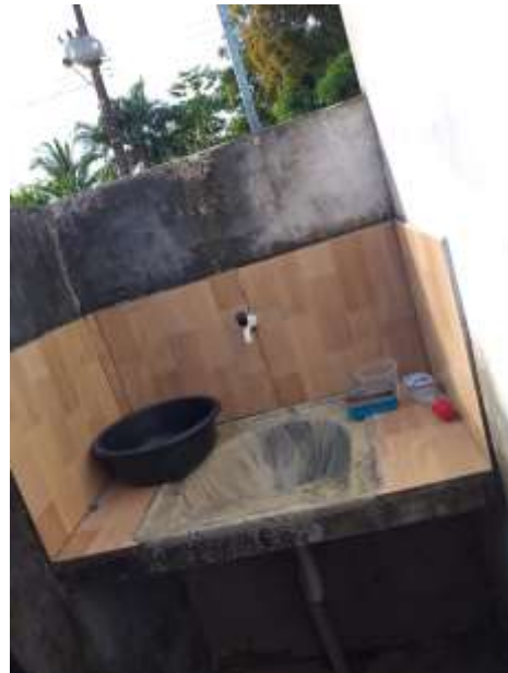
Figura 12: Ambiente Existente Atualmente.
