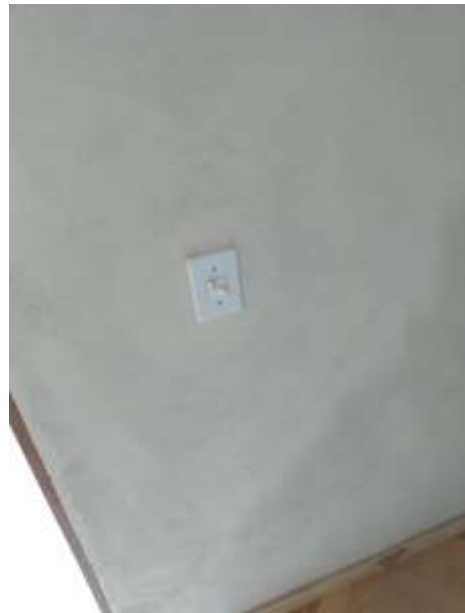
Figura 06: Ambiente Existente Atualmente.
