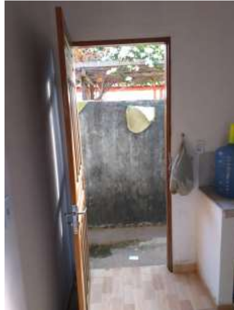
Figura 16: Ambiente Existente Atualmente.
