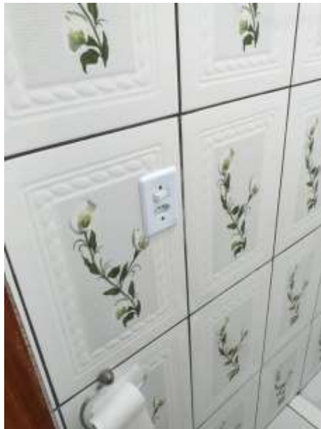
Figura 17: Ambiente Existente Atualmente.
